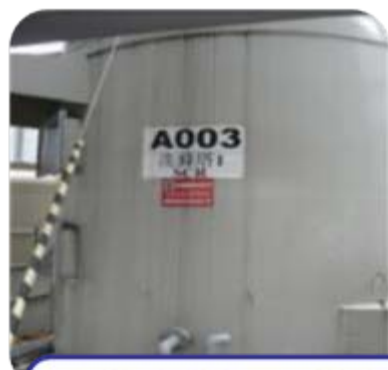
洗滌塔(處理酸鹼 廢氣)-裝設PH計
