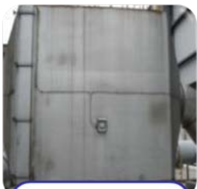
吸附設備裝設 入口溫度計及 壓差計
