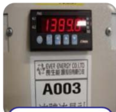
洗滌塔(處理酸 鹼廢氣)-裝設 液體流量計
